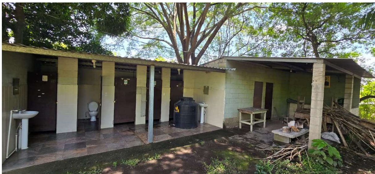
Figura 16 Fotografía de vista hacia servicios sanitarios actuales.
