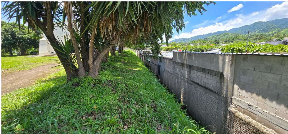
Figura 13 Fotografía del costado sur del terreno.
