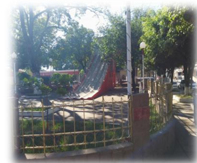
Fotografía 6: Verja y muro perimetral.
