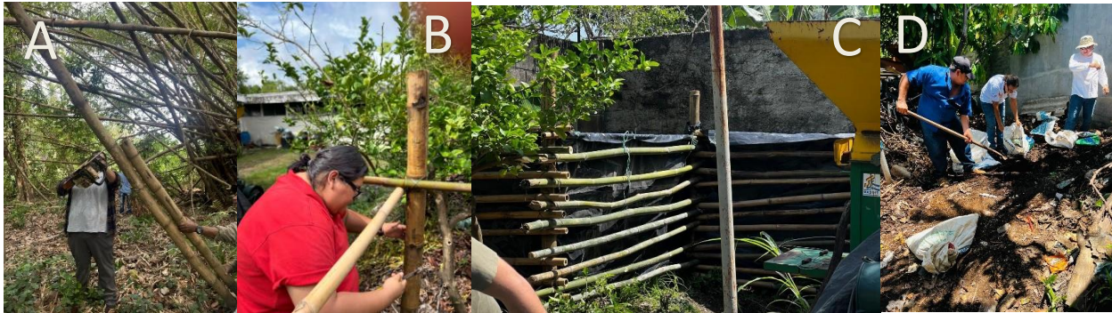
Imagen 14. Establecimiento de caja compostera en Agencia San Vicente. A) Recolección de bambú como materia prima para realizar la caja compostera. B) Armado de la estructura de la caja. C) Encarpetado de la caja. D) Recolección de material para introducir a la caja de compost.
