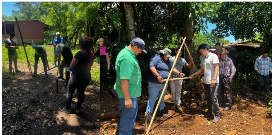
Imagen 28. Construcción de un nivel tipo “A” para trazo de curvas a nivel y desnivel.
