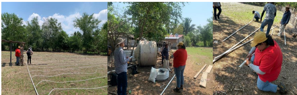
Imagen 9. Instalación de Sistema de riego en Santa Cruz Porrillo.
