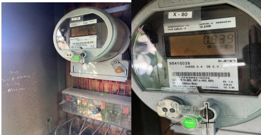
Figura 12: Medidor principal de la organización multi-horario punta valle con multiplicador x80.
