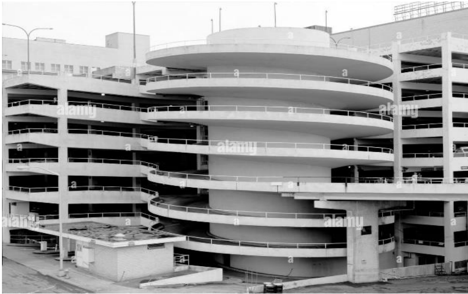
Figura N°3. Referencia a estacionamiento en varios niveles de la construcción. 17
