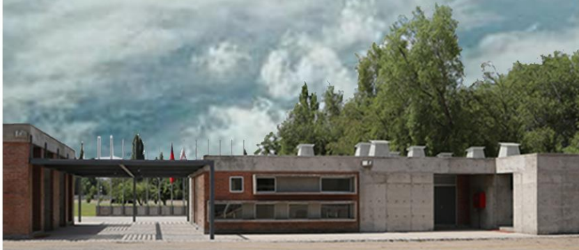
Fotografía 09. Fachada Principal CE Chile
