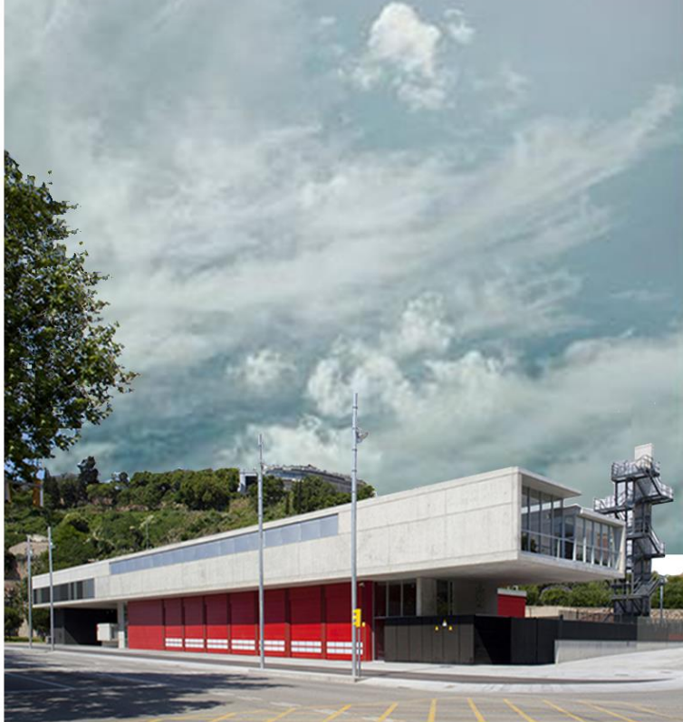
Fotografía 6. Estación Ave Fenix, fachada principal
