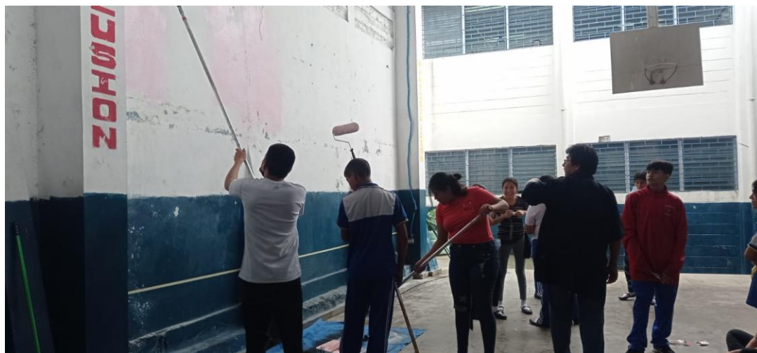
Imagen 4: Preparación de muro. Fuente: Alexander de la O
