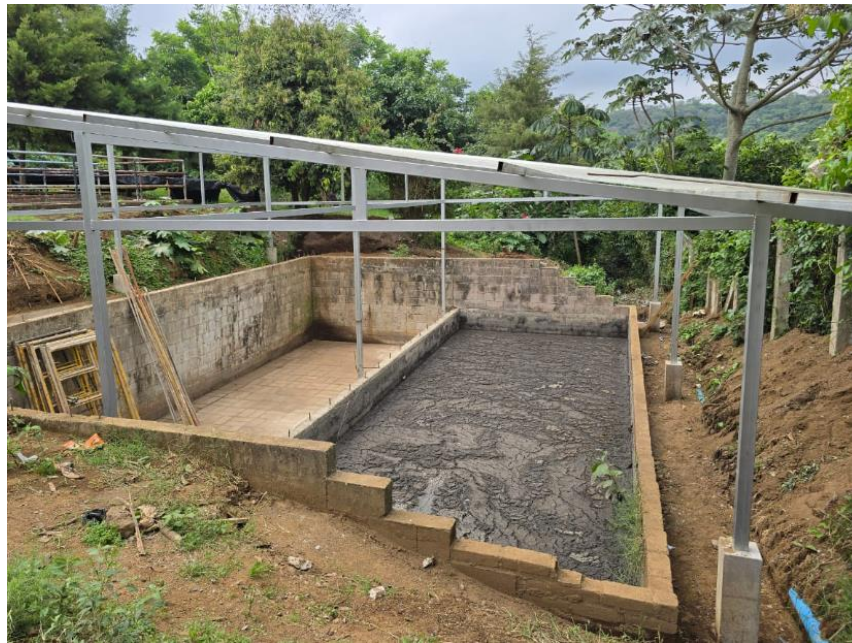
Fotografía de pila con lodos residuales de la PTAR Juayúa, obtenida de la Unidad de Medioambiente, Alcaldía Municipal del distrito de Juayúa.
