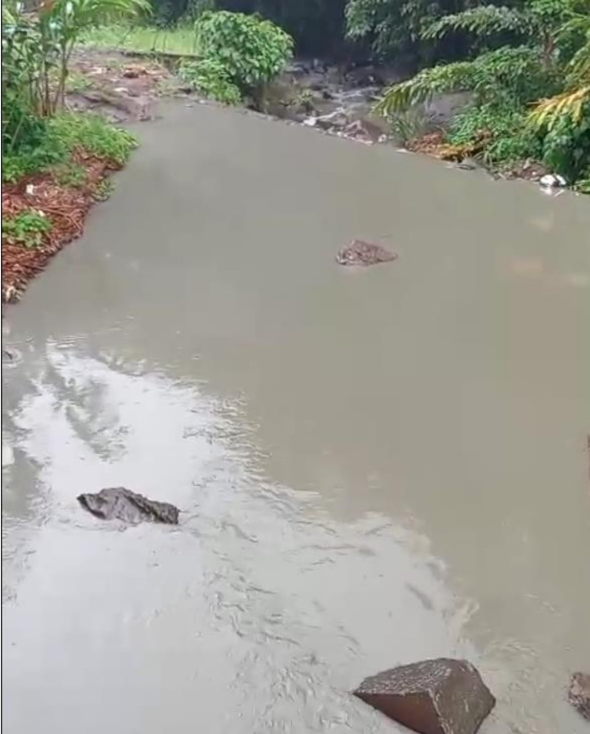
Fotografías del río Sensunapán o Grande de Sonsonate, a una distancia aproximada de quinientos metros aguas debajo de la quebrada La Cachimba, proporcionadas por el señor Pepe Batres.
