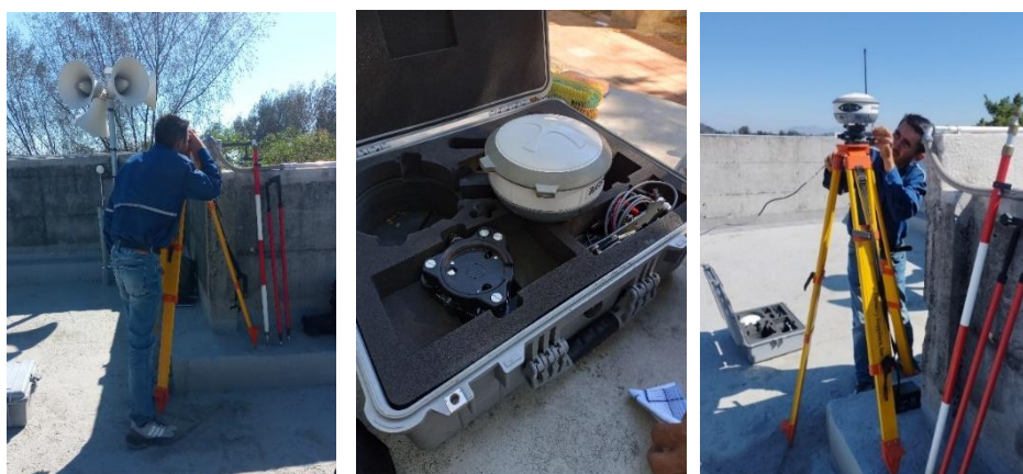
Figura 39. Instalación de la base
