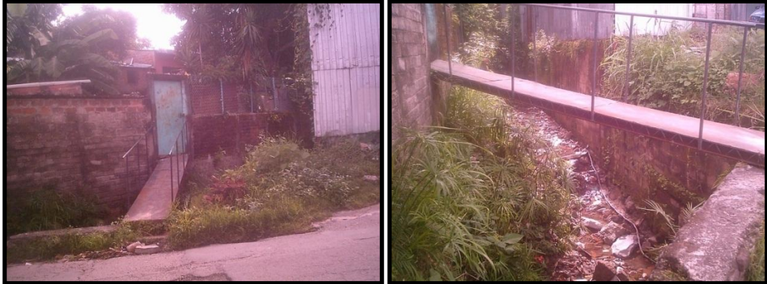
Imagen 16.y 17. Puente Col. El Triunfo. Quebrada Las Lajas
