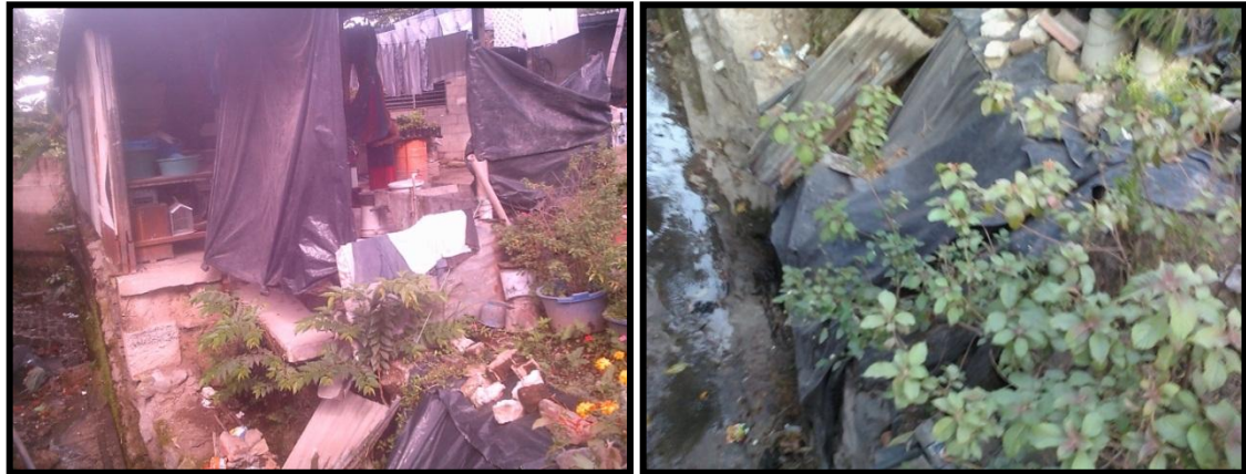
Imagen 18.y 19. Medida para evitar la infiltración de agua. Habitante Col. El Triunfo Quebrada Las Lajas
