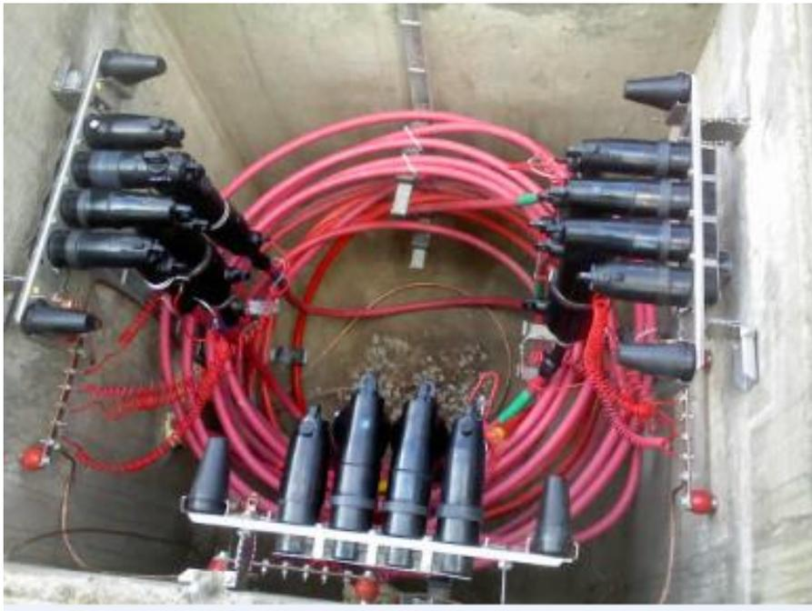
*Figura 3. 18.* Conexión de los inversores.
