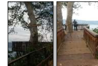
Imagen 24: Miradores en el recorrido del sendero
