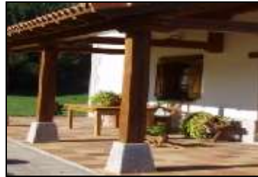
Imagen 41: Columna de madera con pedestal de concreto
