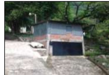
Imagen 30: Caseta de bombeo
