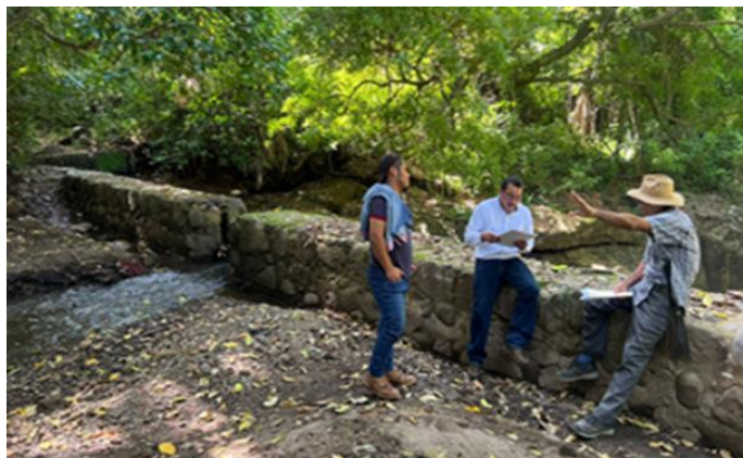
Figura 13. Inspección para otorgamiento de permiso en río Cuyagua de Zacatecoluca.
