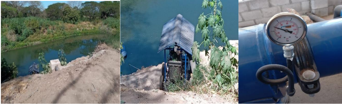
Figura 5. Inspección técnica en río Grande de San Miguel.
