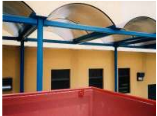
Cubierta traslúcida en pasillos exteriores
