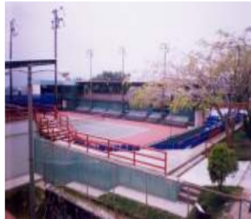
Fotografía muestra área de canchas y circulación exterior
