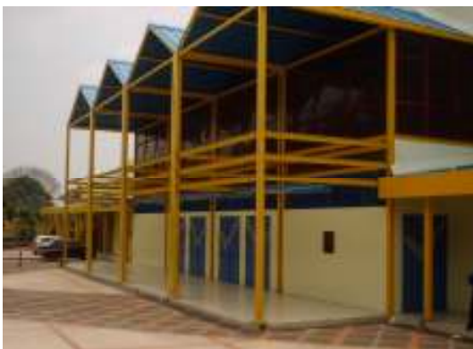
Elevación posterior de edificio de Gimnasio
