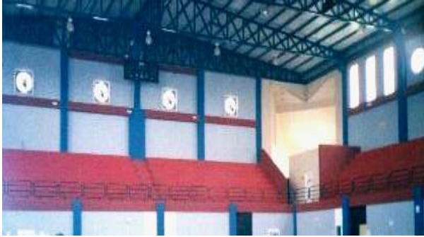
Fotografía muestra estructura de techo
