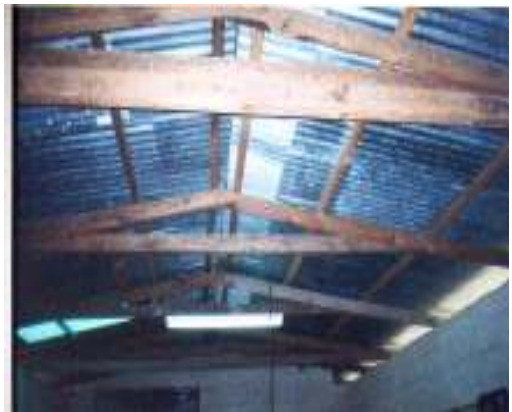
Fotografía presenta estructura de techo
